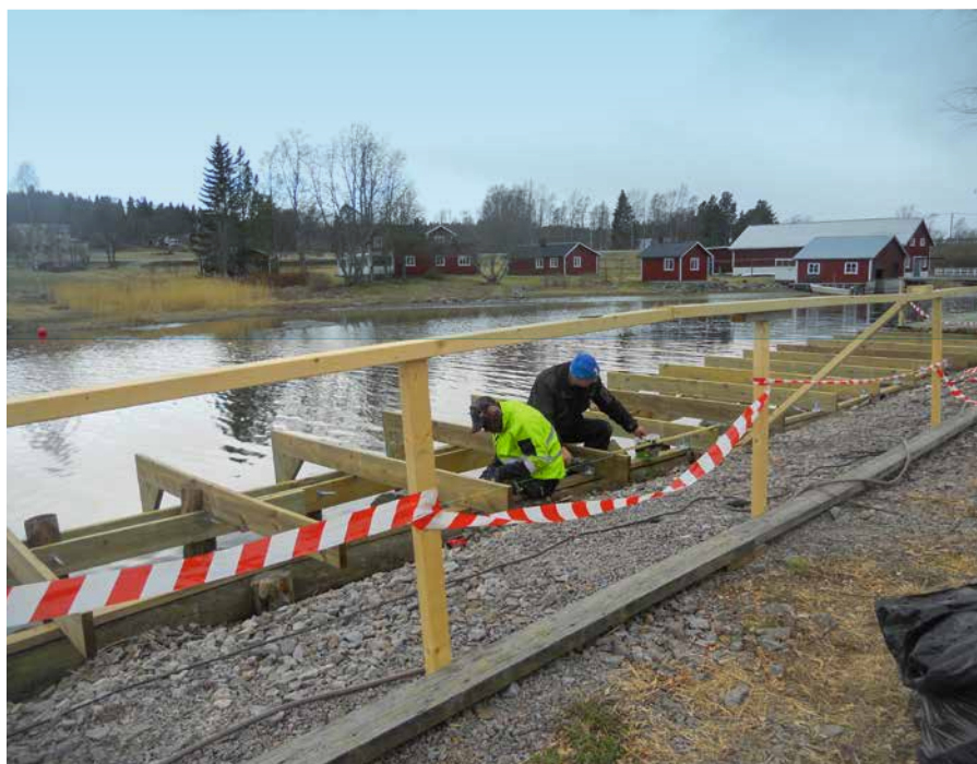
▲ Κατασκευάζοντας μια νέα πλωτή αποβάθρα στο Tynderö.
