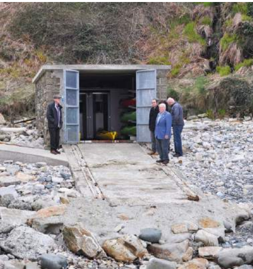
▲ Renovierter Bootsschuppen für Kajaks in Fort Dunree.
