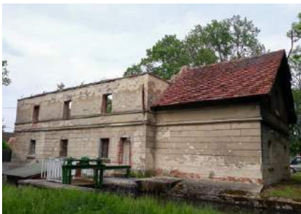
▲ Aus dieser verlassenen Wassermühle könnte ein Fischzuchtmuseum werden.
